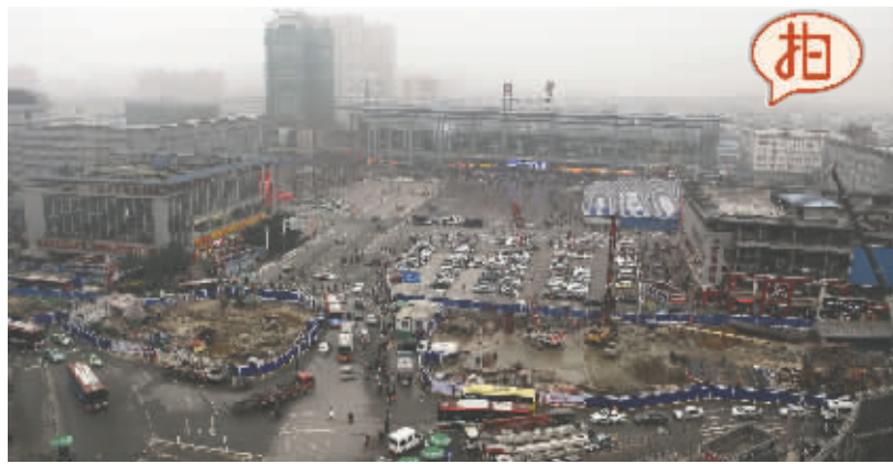
火车北站节点开始施工
