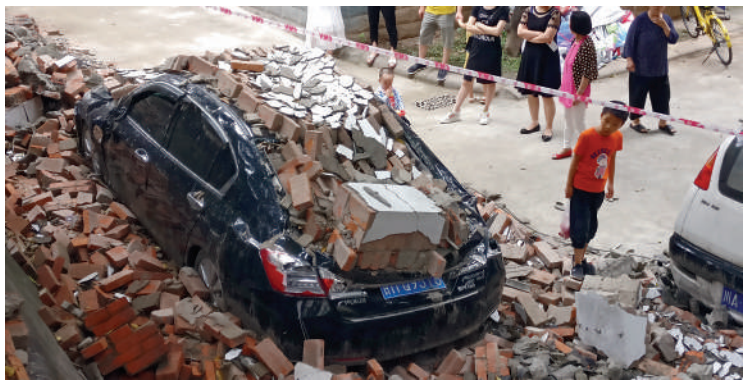
陆女士的汽车被倒塌的围墙砸中
