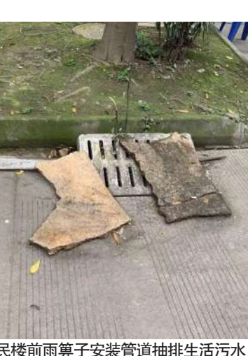
居民楼前雨篦子安装管道抽排生活污水
