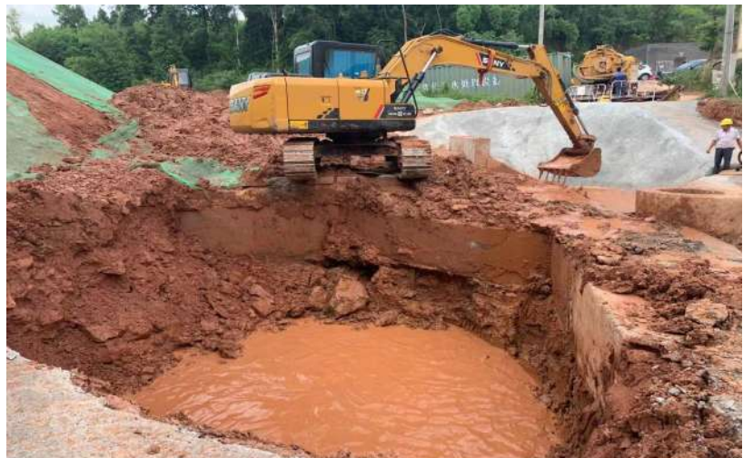
新建的污水收集池
