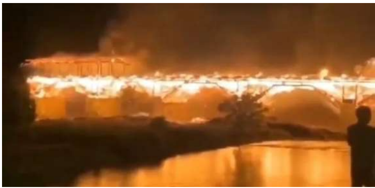
万安桥失火现场
