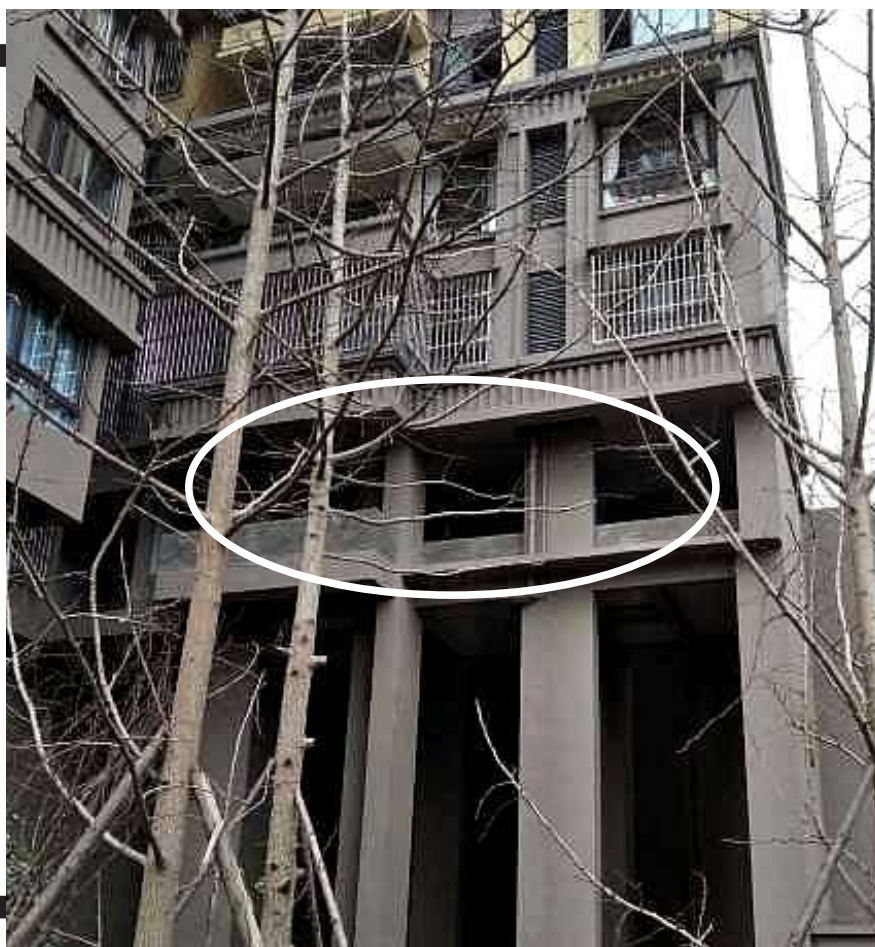
小区架空层在每栋住宅楼的3楼
