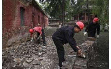
工作人员在洪洞县广胜寺进行抢修
