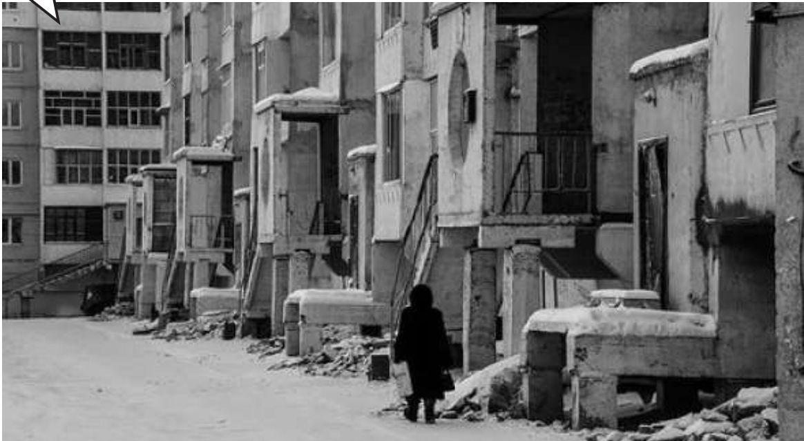
在俄罗斯雅库茨克等西伯利亚城市中，永久冻土融化导致地基软化，损坏了城市内的建筑物 图据中国科学报
