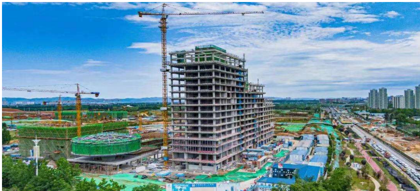
北京凝思软件股份有限公司西南总部落地成都锦江区白鹭湾科技生态园，图为正在建设中的白鹭湾科技生态园 图据锦江融媒
